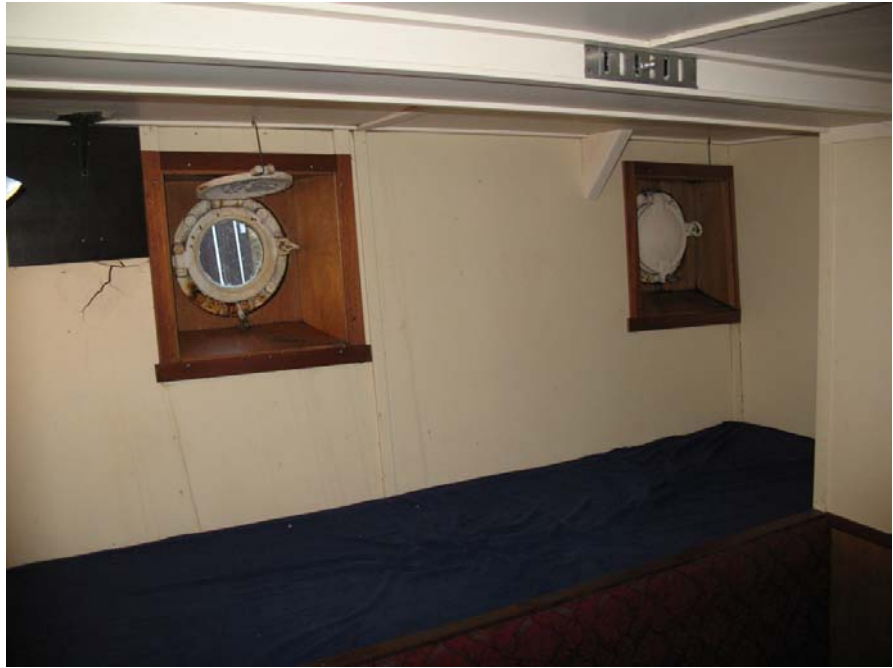
Tegn på lekkasjer rundt lysventiler og ovenfra dekk.
