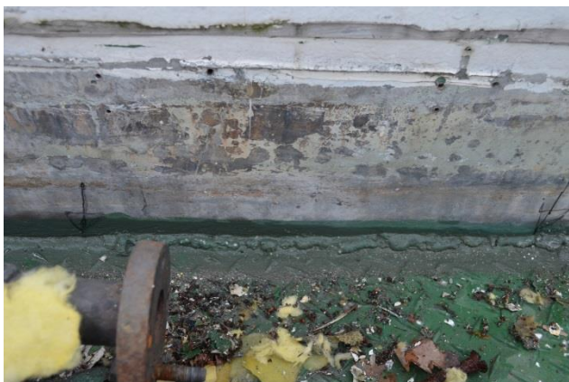
Sveisen som en kan se midt i bildet, og som knytter styrhuset til dekket, fremstår svært dårlig.
